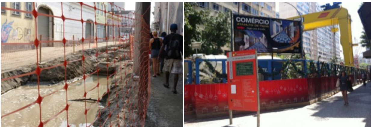
Figura 1 Obras VLT Gamboa - Obras Metro Leblon , 2016
